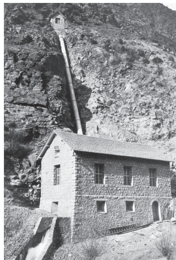
Central en construcció 1932. © FEDA
