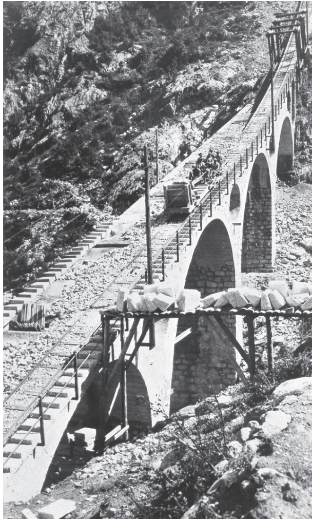
Pont Tresoles en construcció 1932. © FEDA
