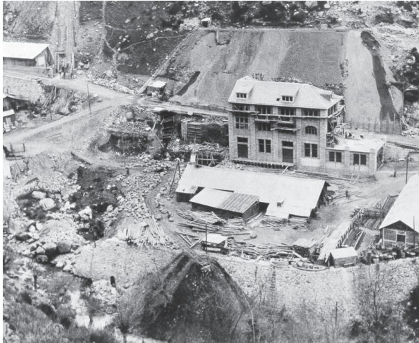
Central en construcció 1932. © FEDA
