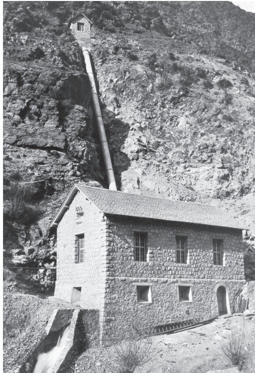
Central en construcció 1932. © FEDA
